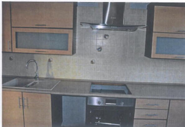
LOKAL NR 2, PIĘTRO
